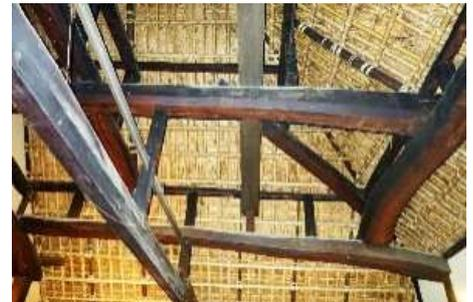
茅は屋根を葺くのに用いる草本の総称で、ススキ(薄、芒)、チガヤ、スゲなどが含まれます。一般的にはススキが使用されます。雨が漏らない仕組みは①茅が湿気による膨張し水分が通らない、②葺地の厚さが十分であれば水分が垂直方向より斜めの茅に伝って横へ移動する、③水分の移動を促進する屋根の勾配などです。
