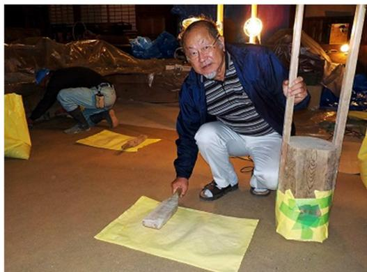
新しい合土の組成は真砂土：100kg、壁土：20kg、消石灰：20kg、苦汁溶液で、コンパネ上でよく混合します。これを敷き詰め、叩くことにより消石灰や苦汁の作用により全体が固まります。
