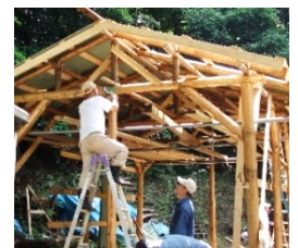
炭焼き小屋の建設
